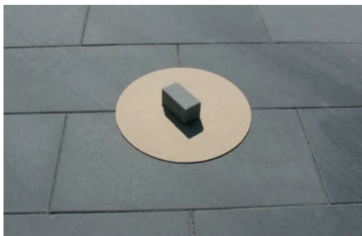
Abb. 104: Ermittlung der Passstücke mit einer Schablone
