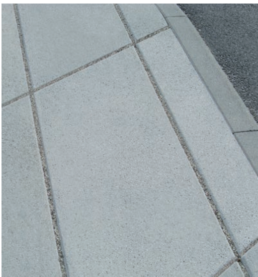
Abb. 100: Randanschluss durch Sonderbauteile mit Scheinfuge
