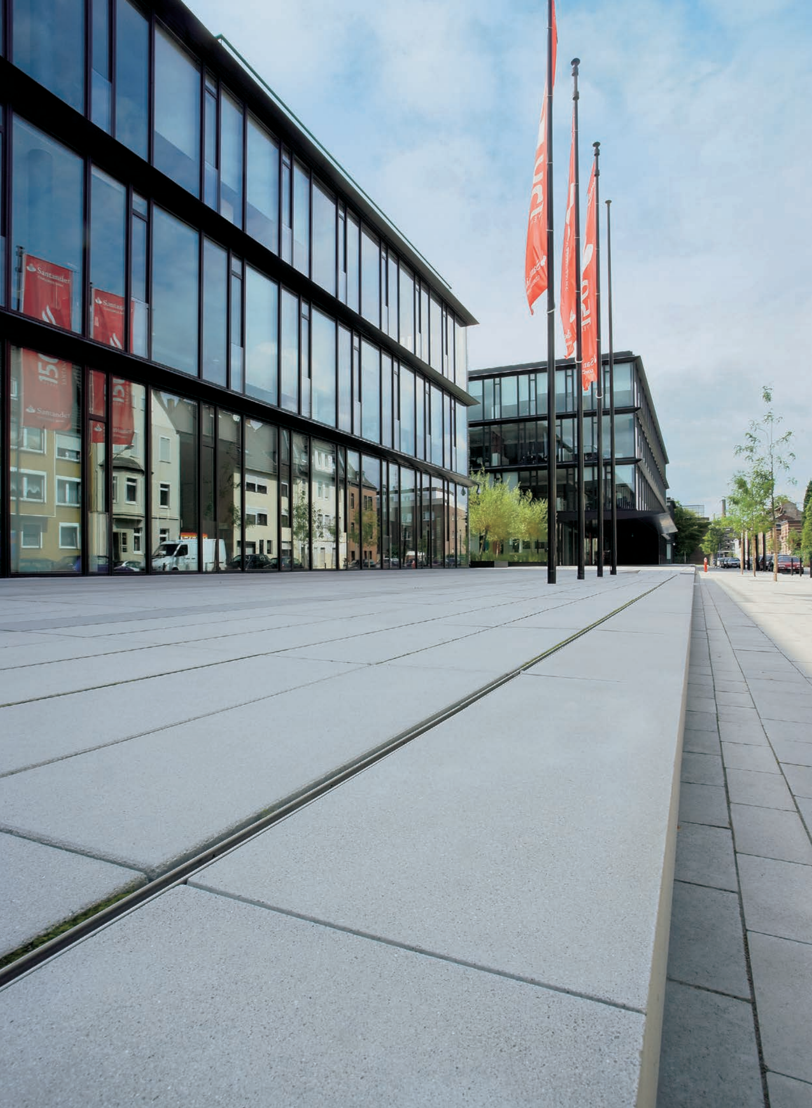
Abb. 69: SCADA und MANUFAKTUR, Mönchengladbach
