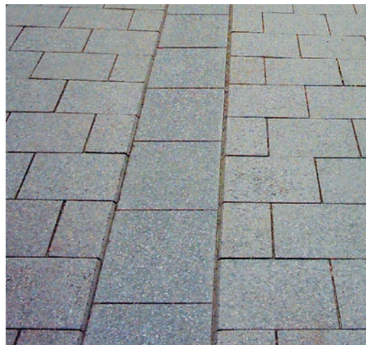
Abb. 93: fertiggestellte Wasserleitrinne
