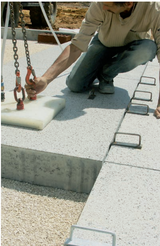
Abb. 82: Aufsetzen von Großformaten mit dem Vakuumgerät auf die Bettung
