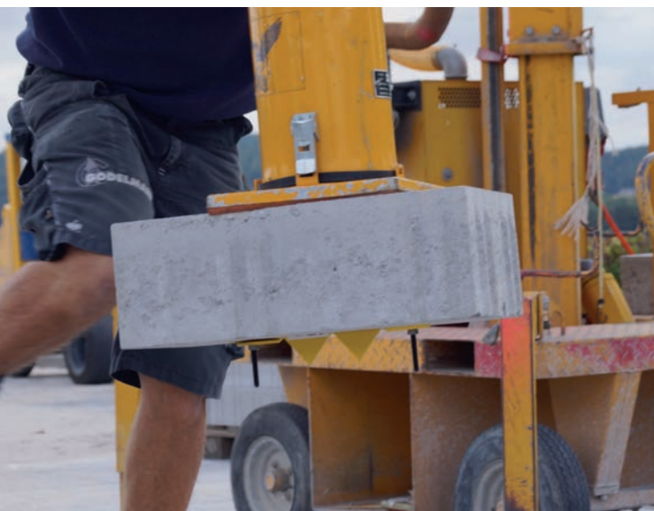
Abb. 35: Verlegung der Ankerschiene
