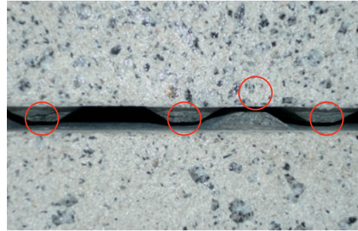
Abb. 96: Auch bei Verzahnungssystemen gilt: Pressverlegung unbedingt vermeiden!
