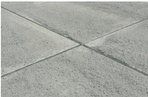
Abb. 95: Fugenmaterial auf der zu befüllenden Fläche zum Trocknen ausbreiten.
