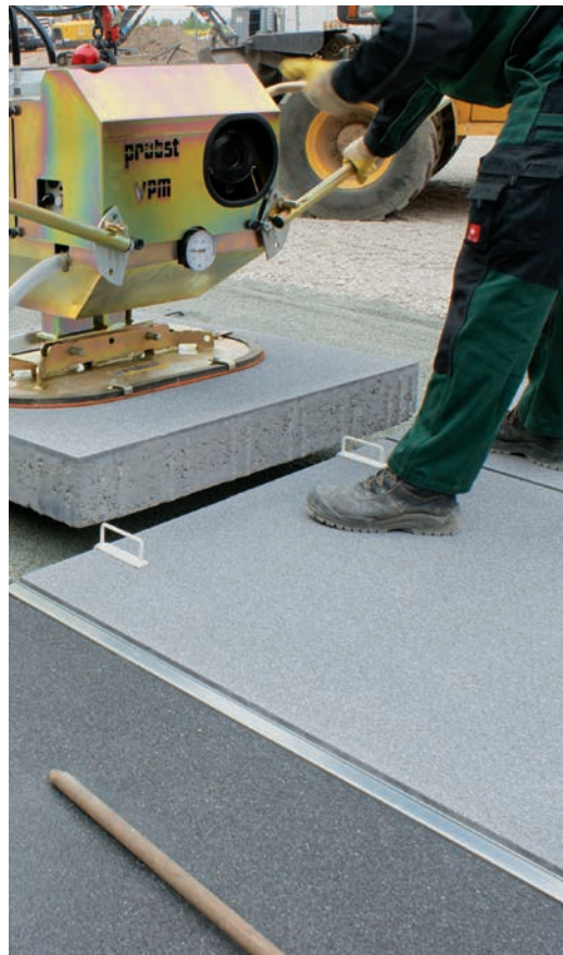
Abb. 80: Verlegung von Großformaten, 1200 x 1200 x 160 mm, mit Fugeneisen
