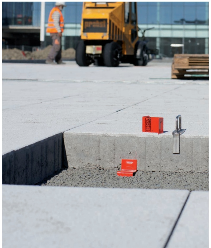
Abb. 38: Erdanker VERSCHI 485/50 im Einsatz
