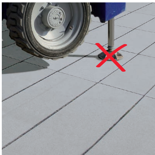
Abb. 86: FALSCH: LASTVERTEILUNG ÜBER NUR EINE PLATTE!
