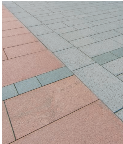
Abb. 83: Einbau unterschiedlicher Materialien mit gleicher Dicke
