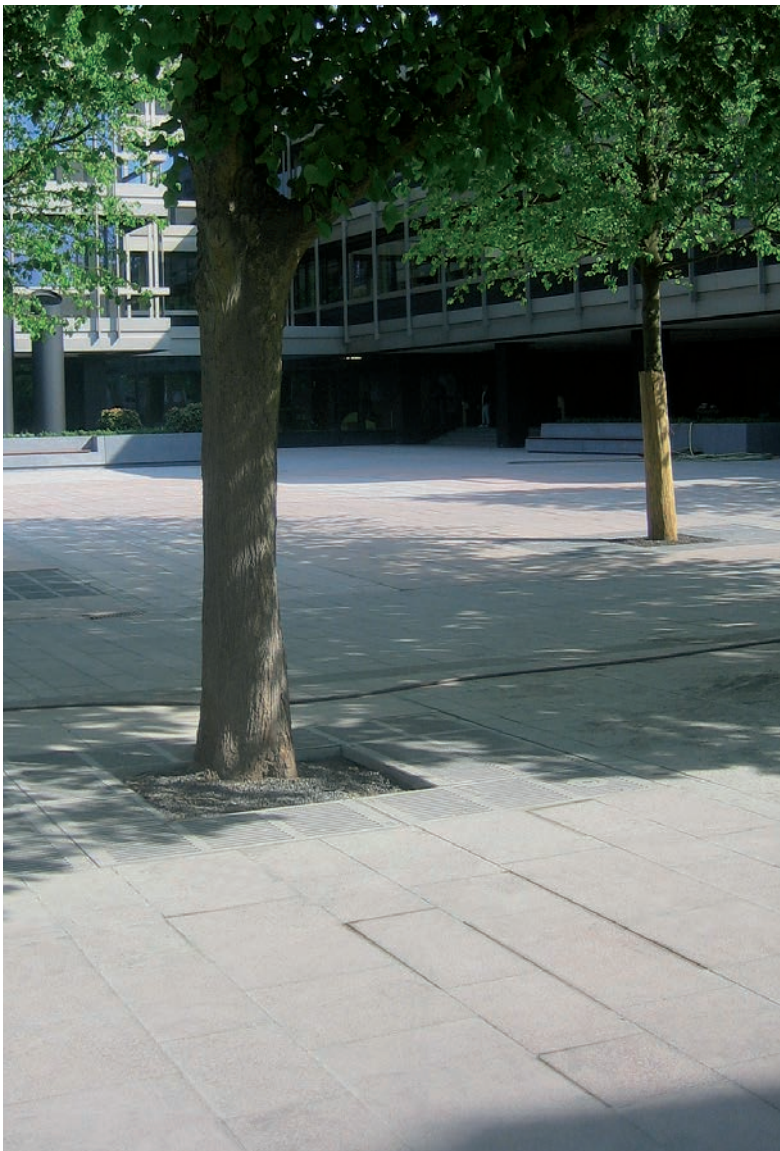
Abb. 39: Bei nicht kalibrierten Großformaten ist der Höhenunterschied bei Streiflicht deutlich sichtbar.
