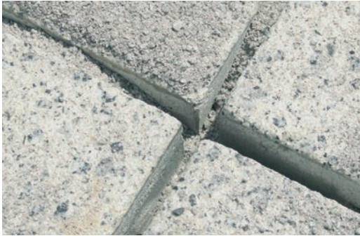
Abb. 94: Füllen der Fugen mit trockenem, den vorgeschriebenen Sieblinien entsprechendem Material
