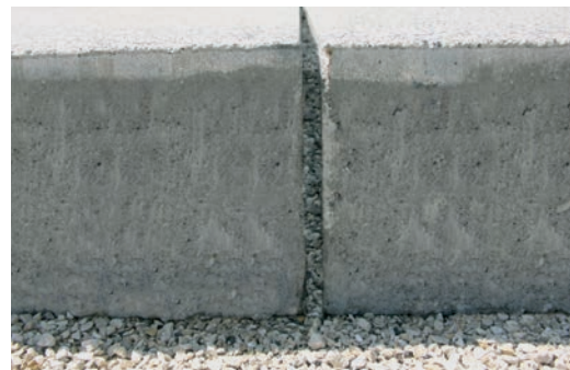
Abb. 97: Gleiches Material für die Bettung und Fugen sorgt für Filterstabilität.
