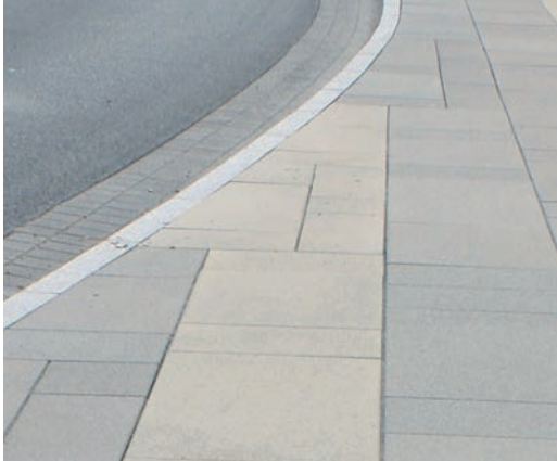
Abb. 99: radialer Randanschluss
