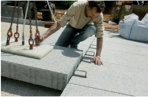
Abb. 81: Verlegung von Großformaten mit Vakuumgerät
