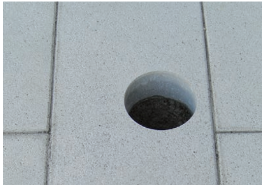
Abb. 106: Einfassung durch Bohrung
