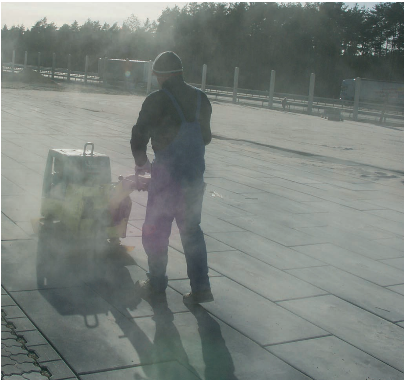
Abb. 98: Abrütteln der Großformate mit Gummimatte zum Schutz der Belagsoberfläche
