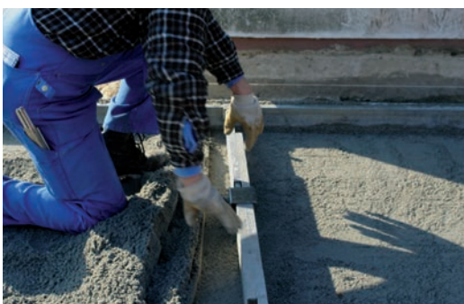
Abb. 78: Bettung aus Splitt-Sandgemisch 0/4, Dicke 20-40 mm (im Mittel 30 mm)
