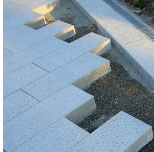
Abb. 101: Ausführung mit dem Schneiden von Passstücken
