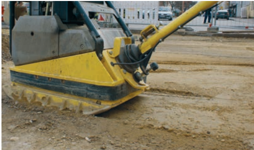
Abb. 76: Verdichten der obersten Tragschicht mittels Rüttelplatte (dynamische Verdichtung)
