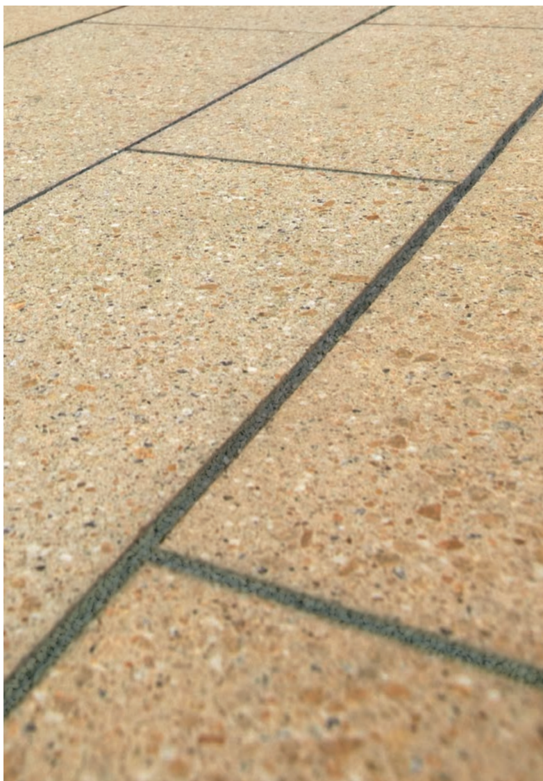
Abb. 46: fachgerechter Fugenschluss
