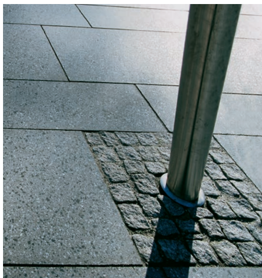
Abb. 107: Einfassung durch Umpflasterung
