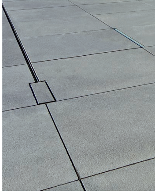
Abb. 92: Einbindung einer Schlitzrinne in den Plattenbelag
