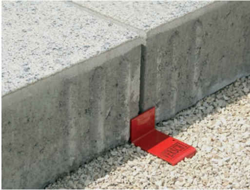
Abb. 87: Montage des Verschiebeschutzes/Abstimmung der Position zum Verzahnungssystem
