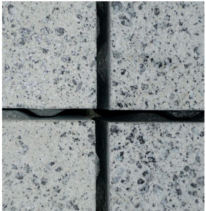
Abb. 43: geradlinig und modern: Kreuzfugen mit scharfkantiger Eckausbildung
