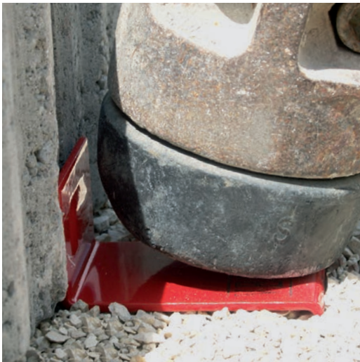
Abb. 88: Der Verschi 485/50 wird eingeschlagen.
