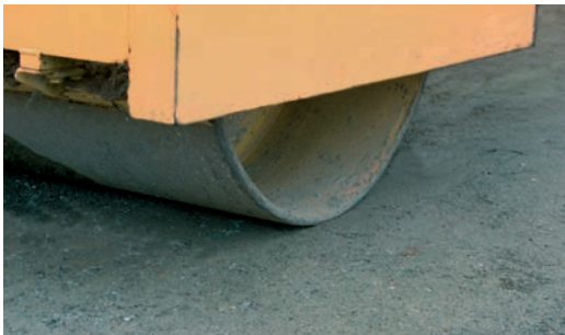
Abb. 77: Verdichten der obersten Tragschicht mit einer Walze (statische Verdichtung)
