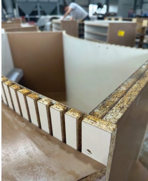
Schalung für einen radialen Sitzblock
